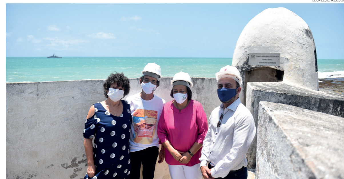
Ordem para retomada das obras de restauração do Forte dos Reis Magos foi assinada pela governadora Fátima Bezerra
