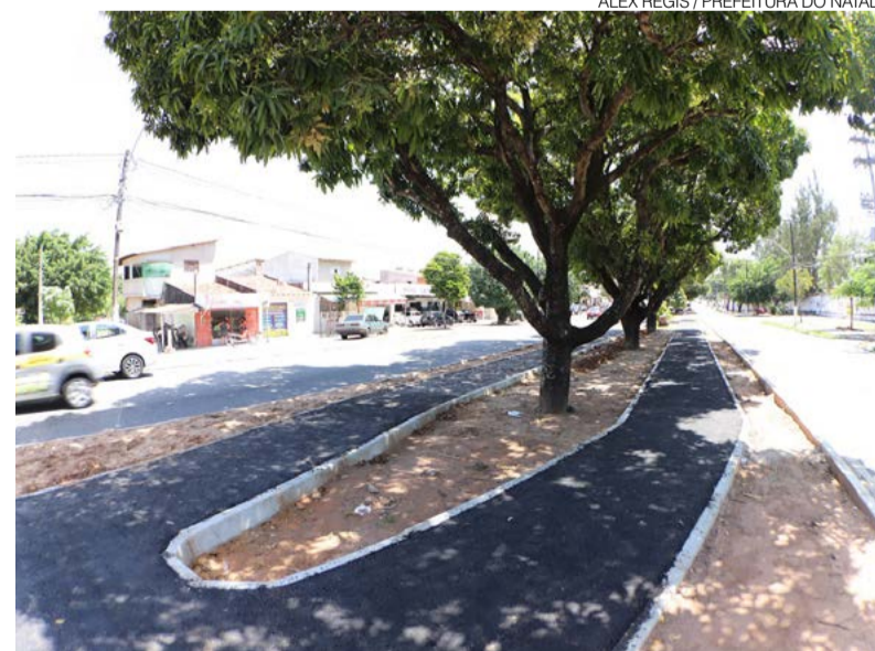
Avenida Itapetinga recebe obras de estrutura cicloviária no canteiro central
