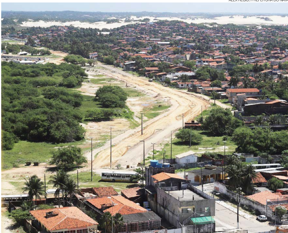
Serviços na rua Maruim se encontram em estágio avançado, com cerca de 30% do cronograma previsto já concluído
